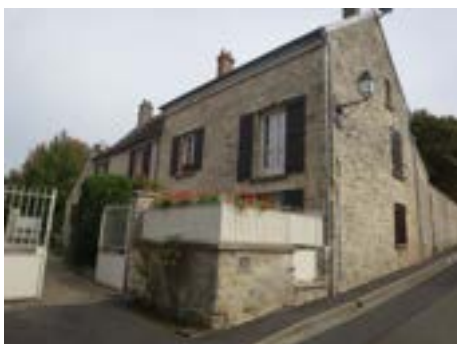
Les anciens bâtiments agricoles du village
