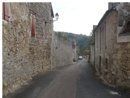
Les murs remarquables
