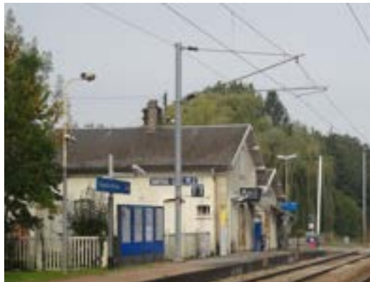
Soutenir la réhabilitation du bâtiment de l'ancienne gare en locaux d'activités.
